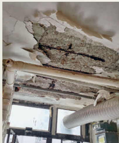
許多長者家居環境破舊，石屎剝落的情況屢見不鮮，也構成很大的危險。
