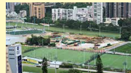
跑馬地地下蓄洪計劃動工。 (政府新聞處圖片)
